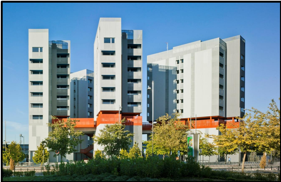
Vista exterior del proyecto. Fuente: ArchDaily.
