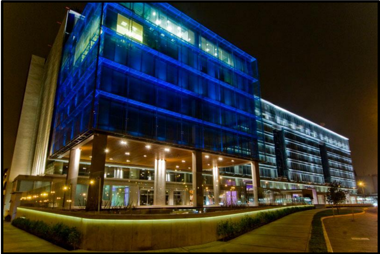
Vista peatonal exterior del proyecto. Fuente: Adondevivir.
