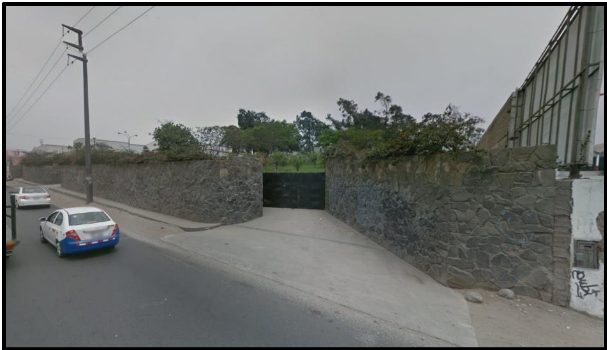
Vista del Frontis principal, colinda con la Avenida Nicolás Ayllón. Fuente: Google Street View
