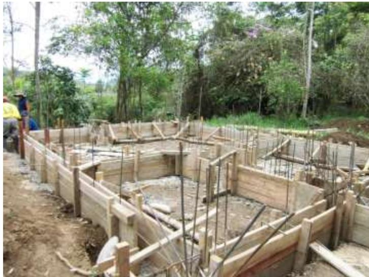
Figura 3.23. Bases – Encofrado
