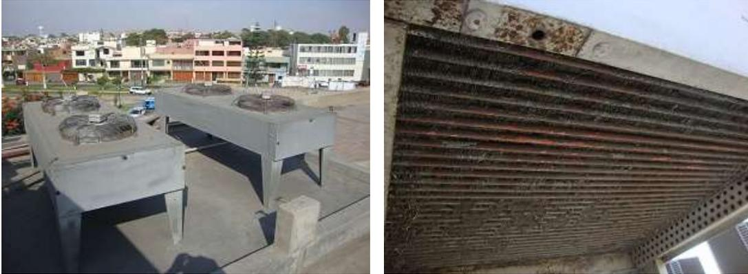
Figura I3: Unidades condensadoras deterioradas
