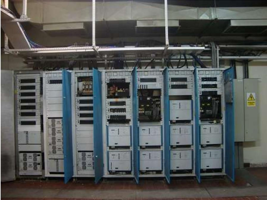
Figura 4: Sistema de Rectificadores 48 VCC
