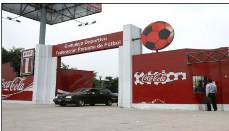
La Videna (San Luis) - Vista Externa
