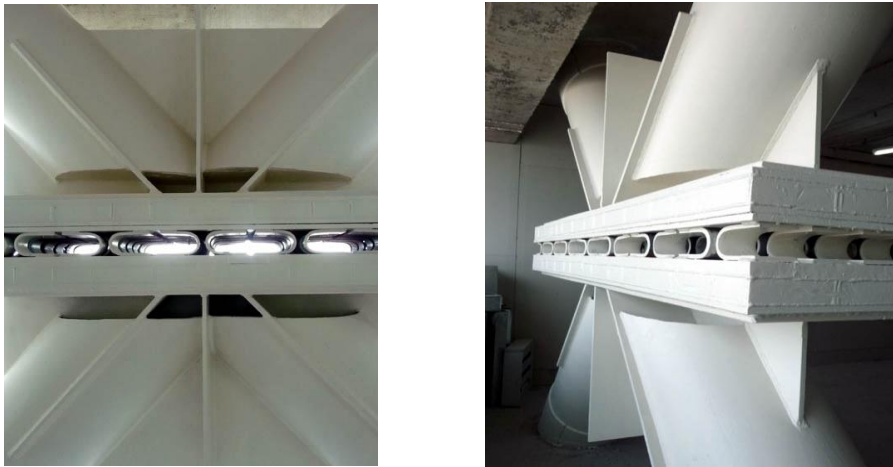
Ilustración 23. Disipadores de Energía de la Torre Titanium La Portada. Fuente: www.sirve.cl
