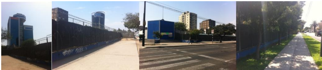
Ilustración 41. Fotos de las fachadas del terreno. Fuente: Elaborado por autores.
