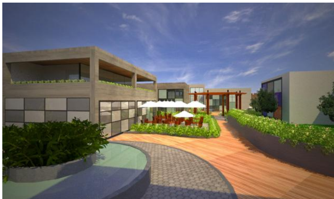
VISTA DE LA TERRAZA DEL COMEDOR
