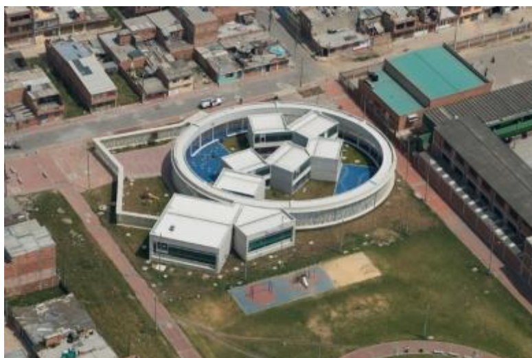
Figura 5. Vista aérea del proyecto "El Porvenir"
