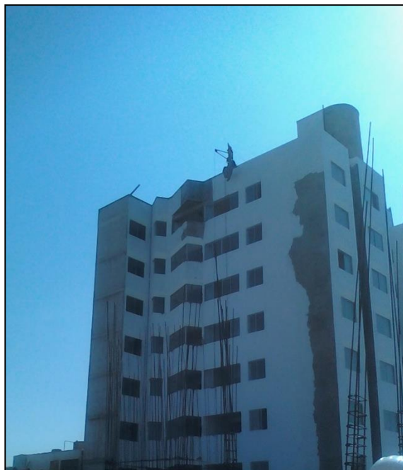
Figura 2 Edificio de Concreto Armado
