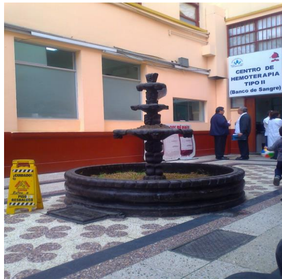
VISTAS DE AMBAS ALAS DE LA EDIFICACION EN FORMA DE “C”
