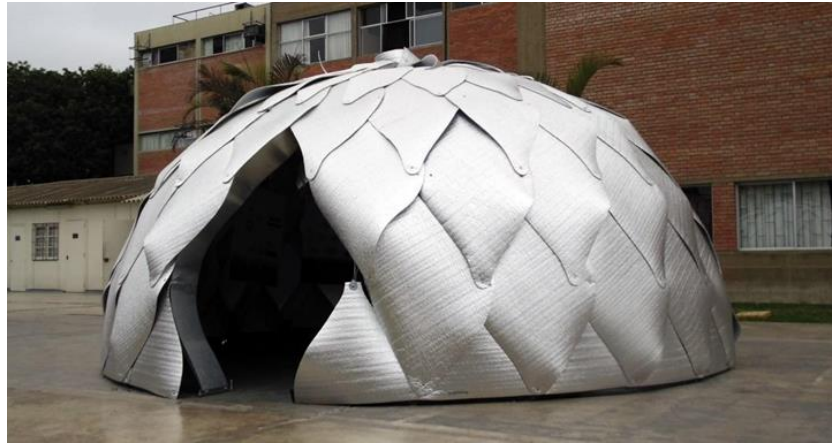
Figura 20. Prototipo instalado de la Matriz - Módulo desplegable de emergencia Fuente: (Bernuy, 2017)
