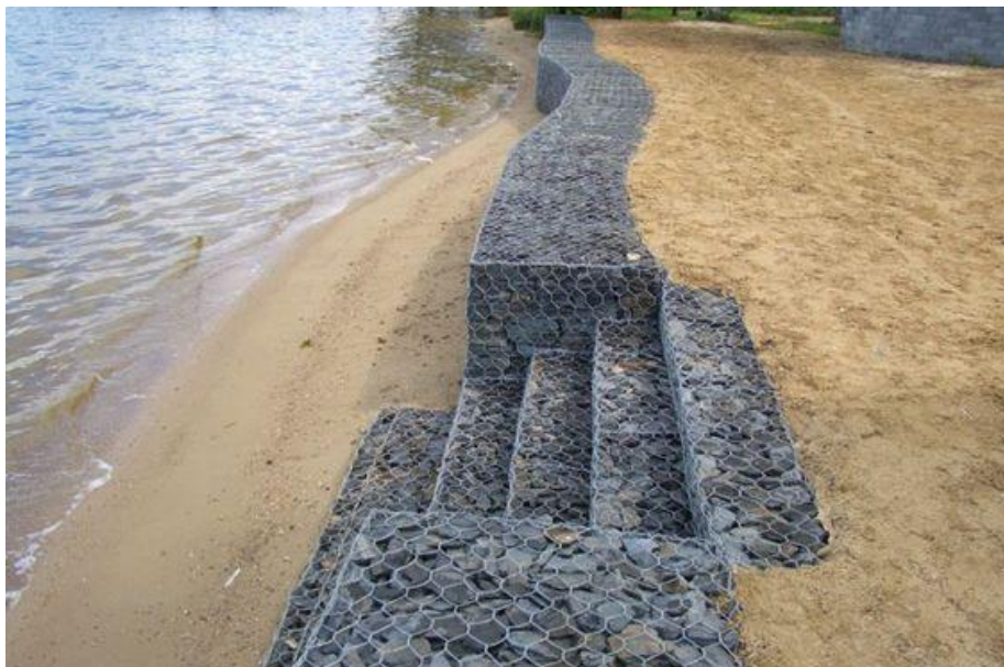
Gaviones de piedra
