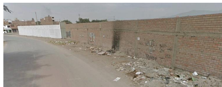
Figura N° 52 Frente Sureste en Av. Los Pinos.
