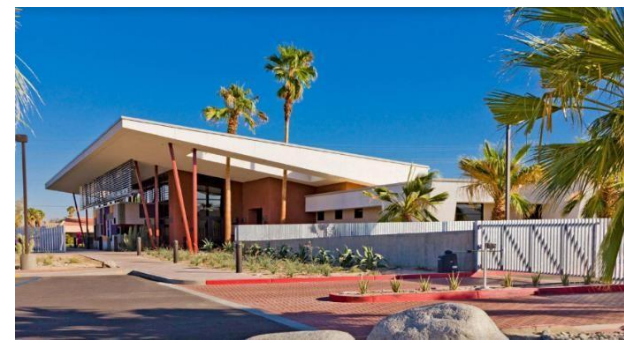
Nota: Se observa el canil donde los adoptantes pueden interactuar con el animal. Fuente: https://www.archdaily.com/237233/palm-springs-animal-care-facility-swatt-miers-architects
