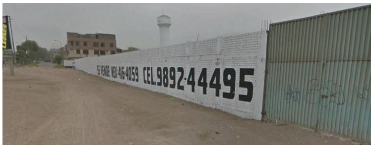
Figura N° 49 Frente Noroeste en Autopista Chillón Trapiche.
