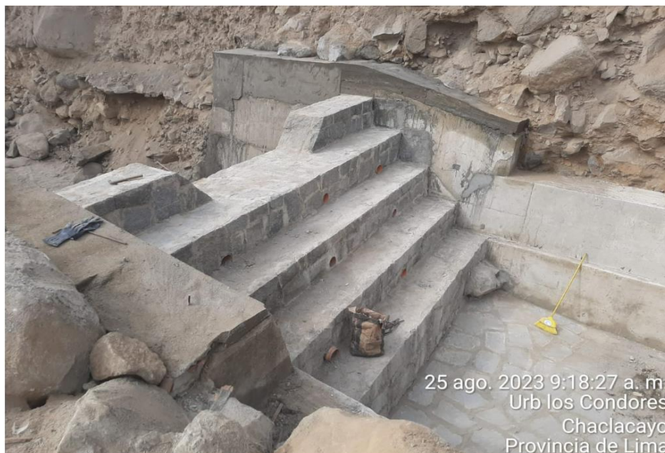
Fotografía de Estado Actual del Dique
