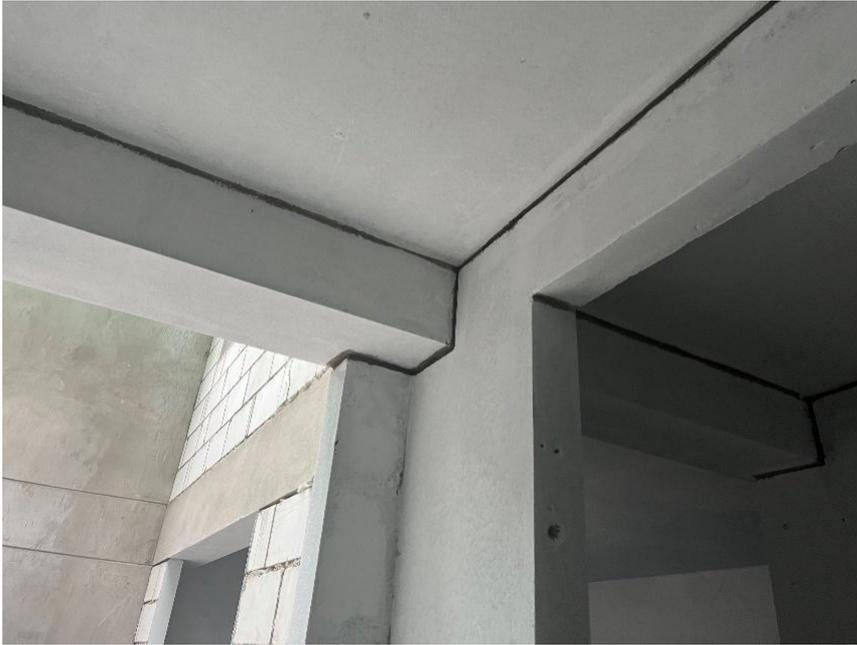
*Nota.* Pintura en interiores sin realizar el procedimiento de lijado.
