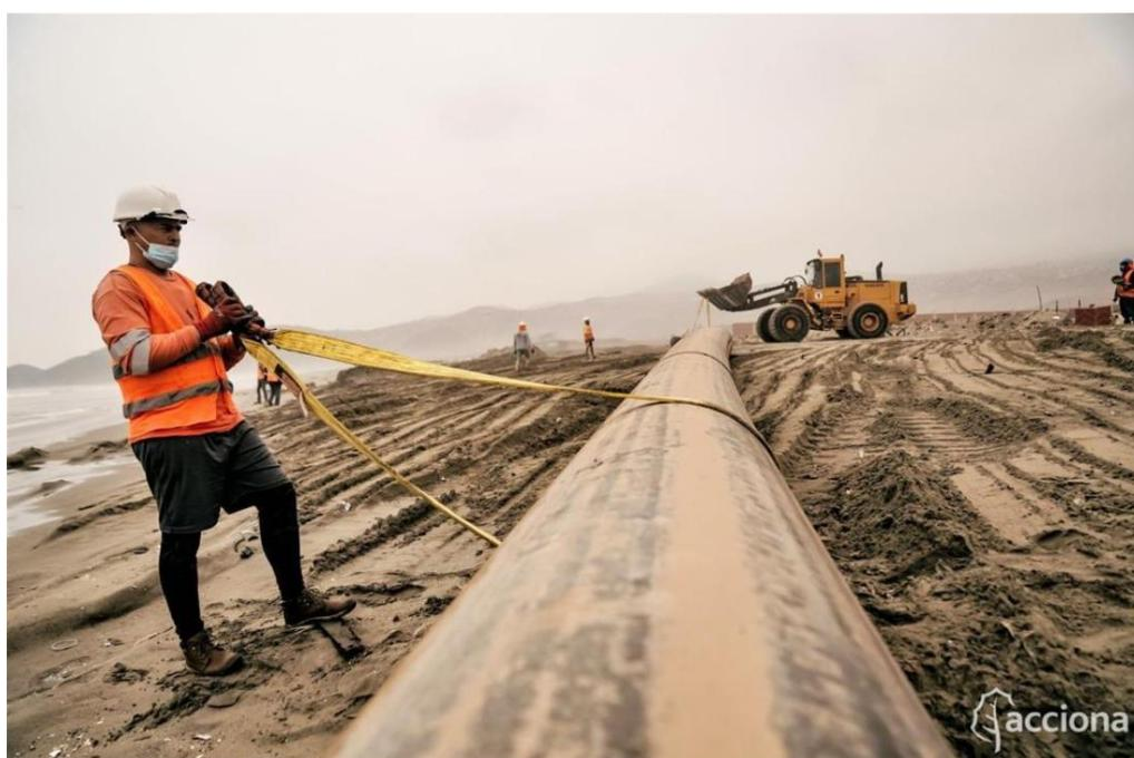
Figura N° 51: Lanzamiento de tubería para instalación.
