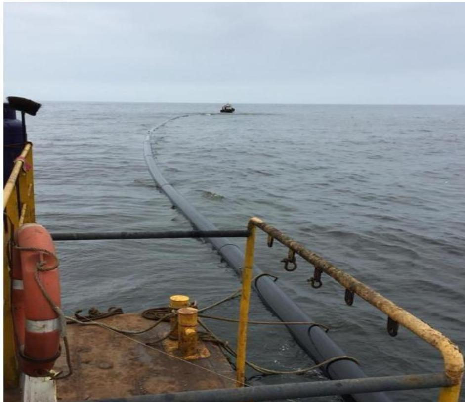
Figura N° 32: Tubería preparada para halado.
