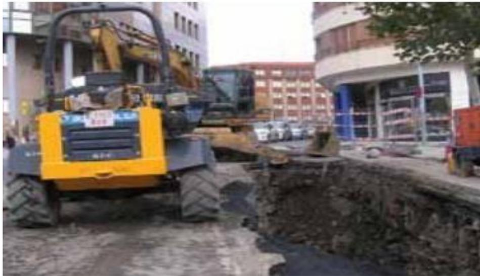
*Figura N° 16: Excavación con zanja.* Fuente: OSALAN – Seguridad en los trabajos de zanja.
