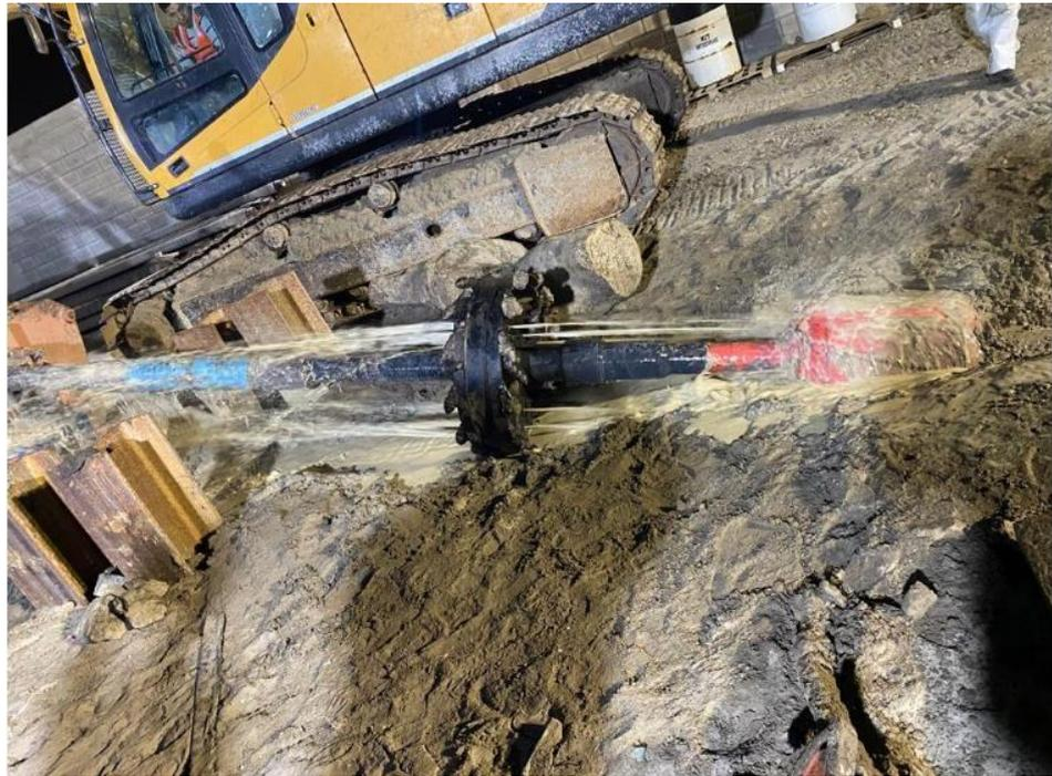
*Figura N° 19: Configuración de sarta de perforación.*
