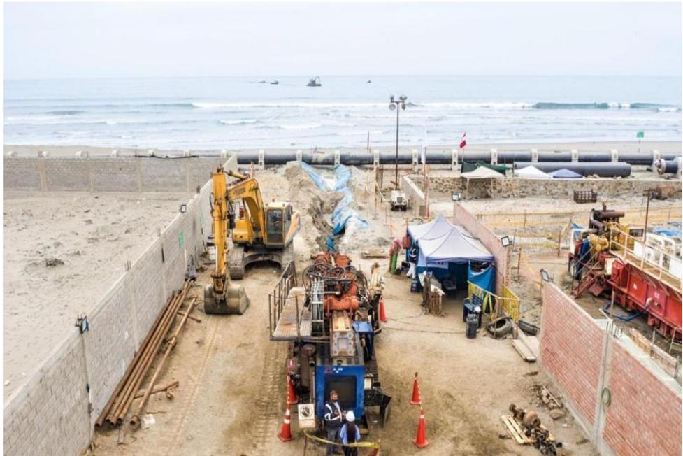
*Figura N° 05: Perforación horizontal dirigida – Proyecto PTAR Pachacútec – Rig Side.*
