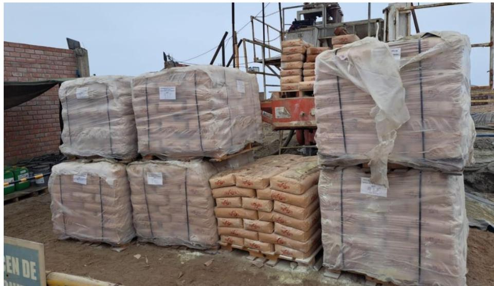
Figura N°37: Bentonita de alto rendimiento. Fuente: Propia
