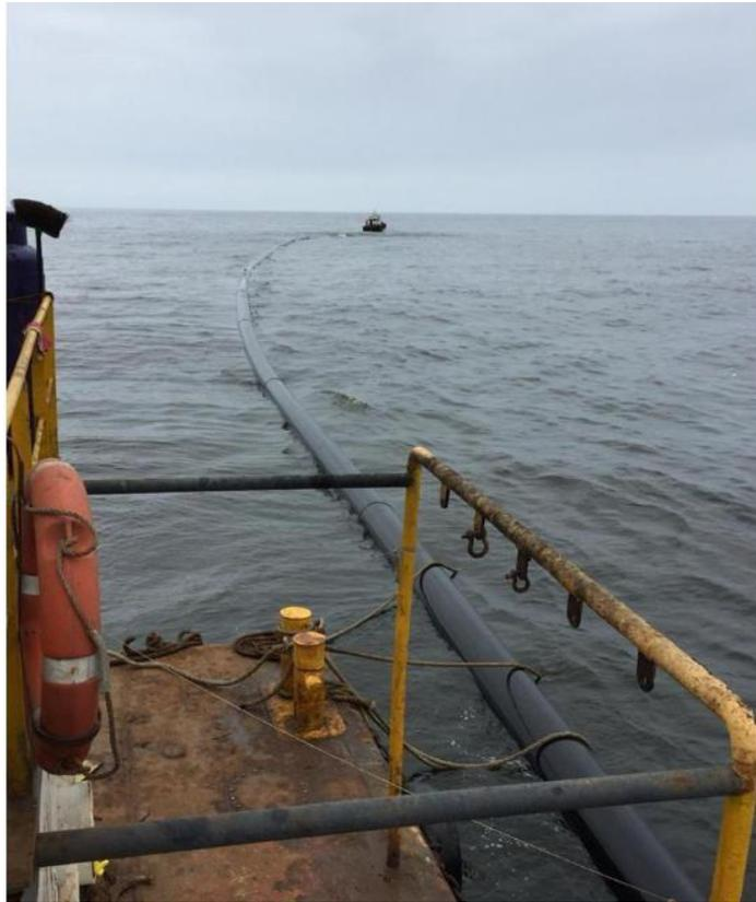
*Figura N° 58: Halado de tubería desde barcaza. Fuente: Elaboración propia.*
