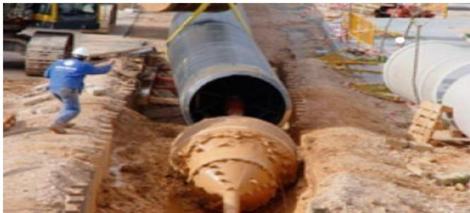
*Figura N° 31: Halado de producto final, tubería HDPE.* Fuente: Catalana de Perforacions.
