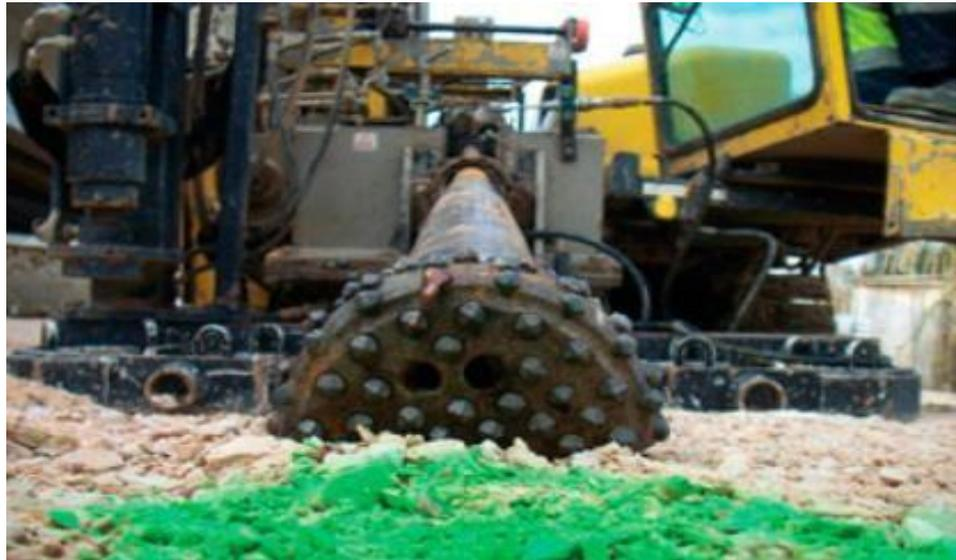
*Figura N° 28: Inicio de perforación piloto* Fuente: Catalana de Perforacions, 2016.
