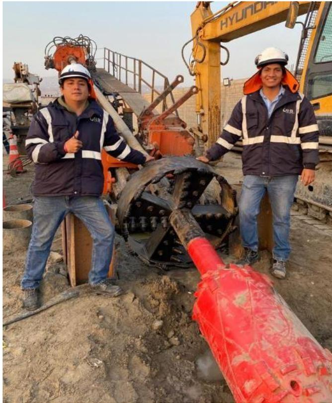
*Figura N° 30: Inicio de ensanche con escariador de 42''.* Fuente: Propia.
