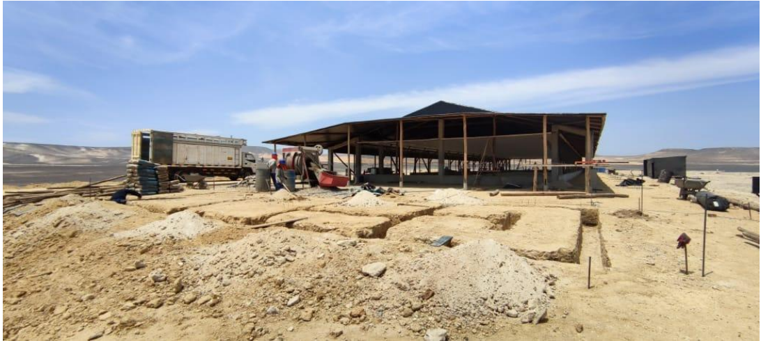
Figura N° 17: construcción de Galpones
