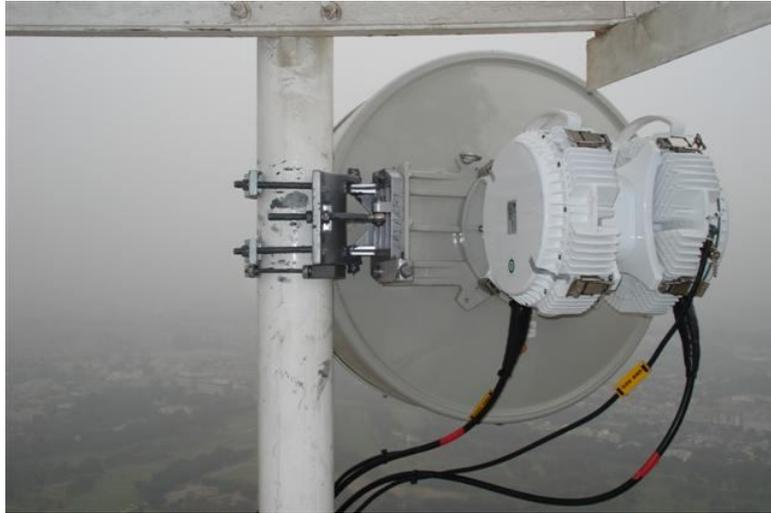
Figura 5.29 Configuración típica 1+1 HSB
