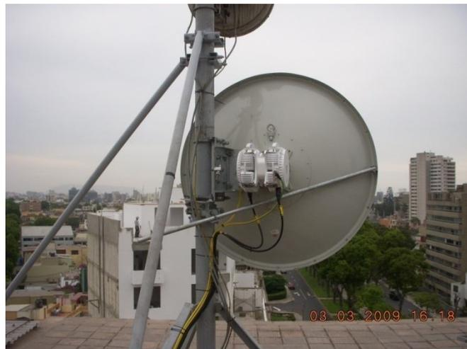
Figura 5.35 Foto de antena MW de 1.2m
