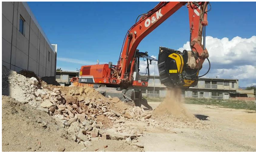
Figura 8. Etapa constructiva: demolición.
