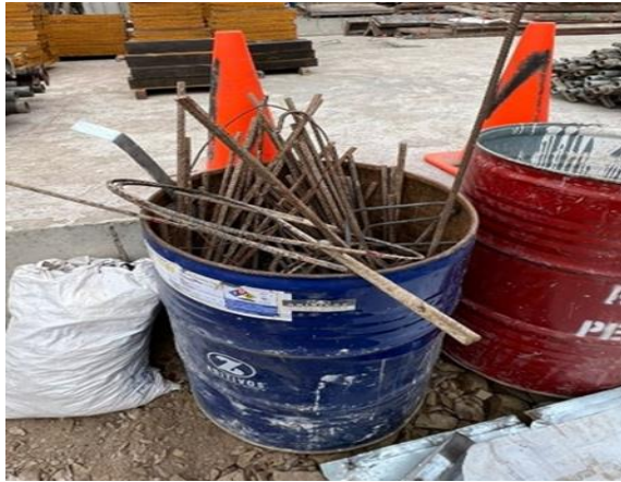
Figura 24. RCD: Varillas de acero.
