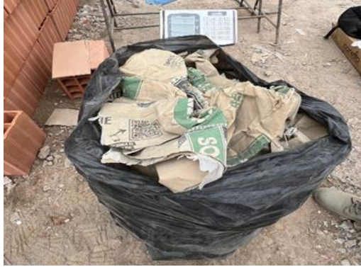
Figura 30. RCD: Bolsas de cemento.
