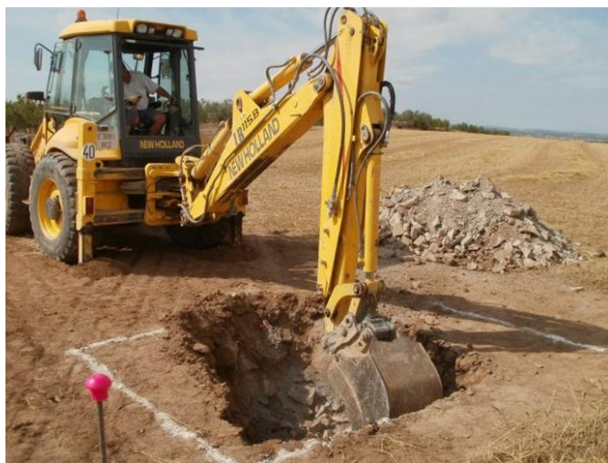
Figura 9. Etapa constructiva: excavación.
