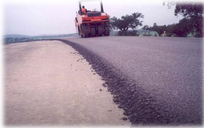
Figura 5. Mezcla asfáltica en finalización. Fuente: Universidad Politécnica de Madrid.
