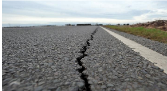
Figura 21. Fisuración térmica
