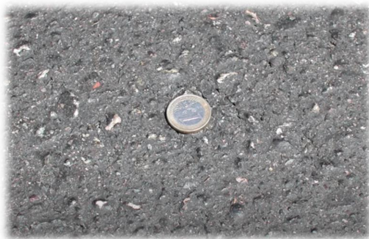
Figura 7. Primer plano de la mezcla asfáltica. Fuente: Universidad Politécnica de Madrid.
