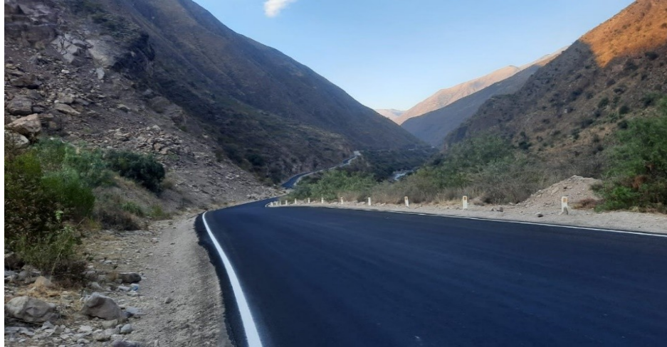
Figura 2: Capa de Slurry Seal sobre base estabilizada Fuente: Elaboración propia (2021)
