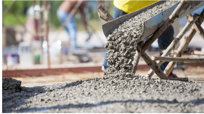
Figura 2. Mezcla de hormigón
