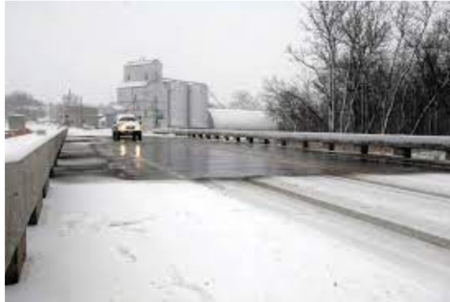
Figura 3. Hormigón conductor aplicado en una carretera
