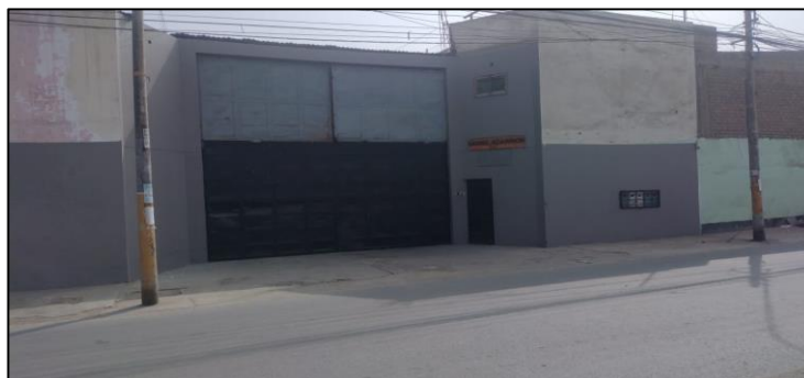
Figura N 12: Imagen de los exteriores de la planta
