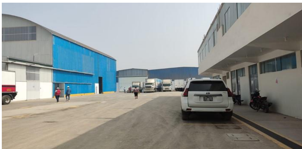
Figura 5. Almacén Central de la CORPORACIÓN BELCEN S.A.C. en Huachipa Elaboración propia
