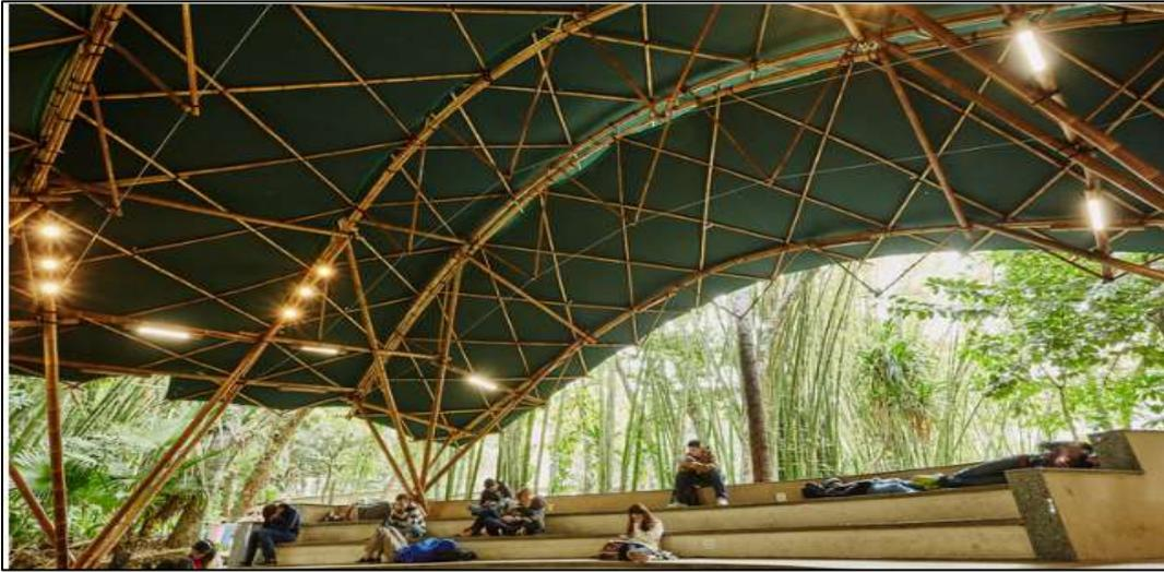
*Nota.* Vista de cubierta textil con estructura de bambú en un auditorio en Brasil. Extraído de bambutec, 2022
