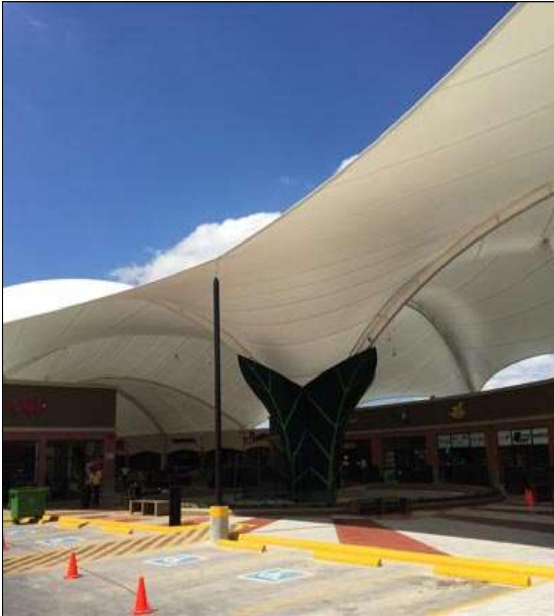
*Nota.* Vista en el cual podemos observar la estructura de la cubierta textil que a la vez protege a las circulaciones peatonales y tiendas comerciales. Extraído de Cubre Membrana Architecture, 2021(<https://cubre.com.gt/en/c-c-eco-centro-los-alamos-2/>)
