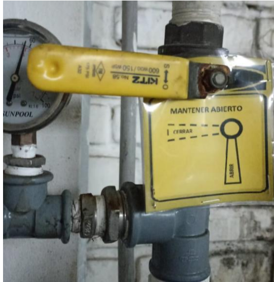
Figura N 45: Control visual de válvula de planta de tratamiento de agua Fuente: Centro oftalmológico
