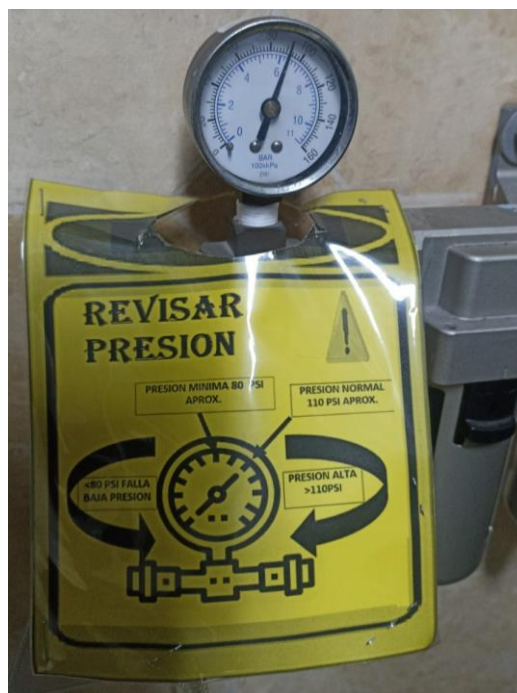
Figura N 50: Control visual de presión de llegada de aire comprimido - Sterivac Fuente: Centro oftalmológico
