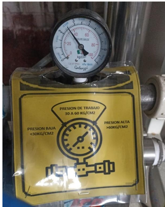
Figura N 46: Control visual de presión de bomba de agua Fuente: Centro oftalmológico
