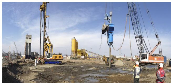
Figura 2: Mejoramiento de suelos con el método columna de grava.
