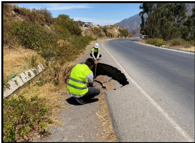
Figura N°51. Socavación del suelo en berma de la vía
