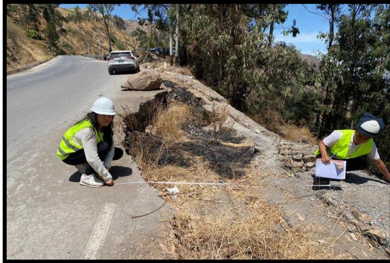
Figura N°50. Erosión severa de la berma
