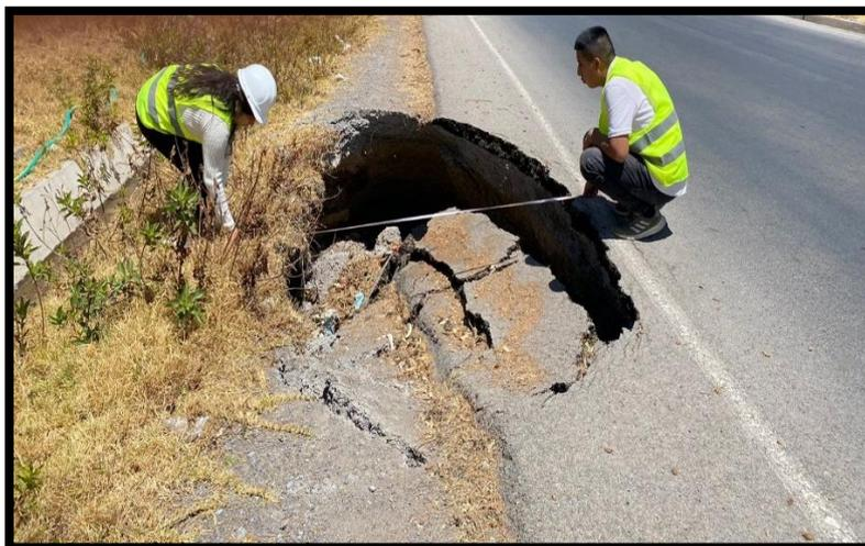
Figura N°52. Socavación del suelo en berma de la vía
