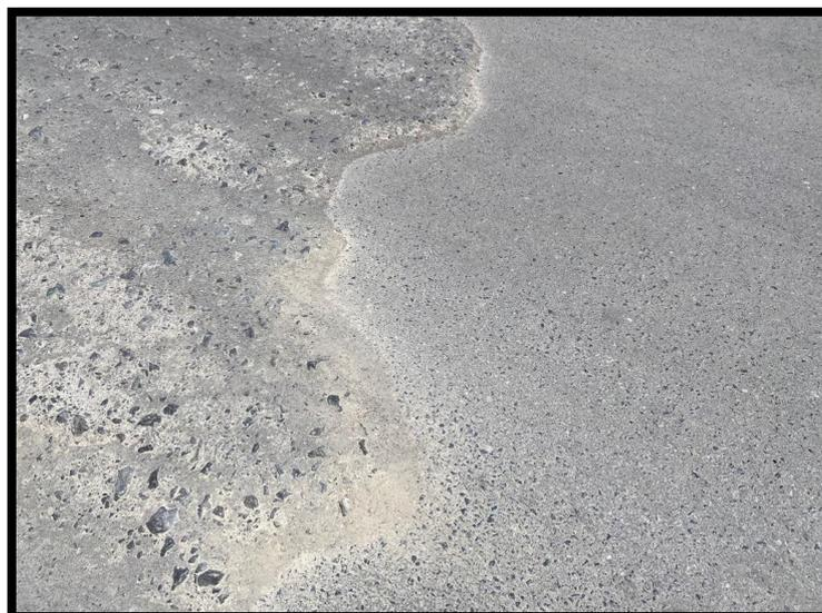
Figura N°53. Erosión y desprendimientos de rocas
