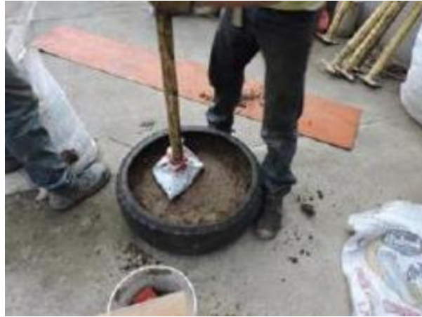
Figura 27. Llenado manual de material seleccionado en la llanta Fuente: Rodríguez (2016)
