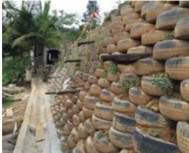
Figura 29. Sistema de drenaje para muros de llantas
