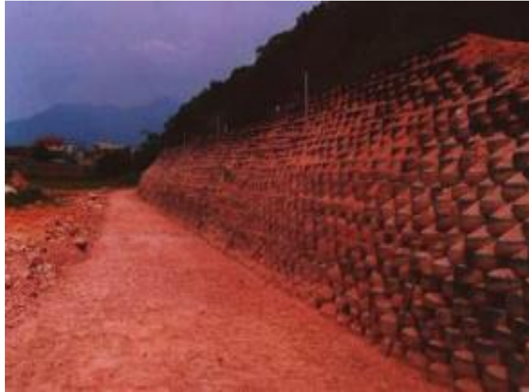
Figura 23. Vista de muros de neumáticos reciclados
