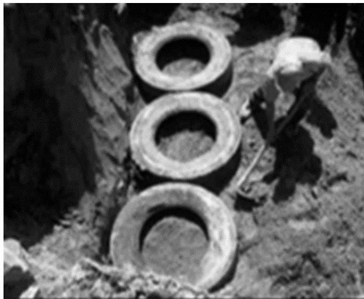
Figura 24. Conformación y nivelación del terreno
