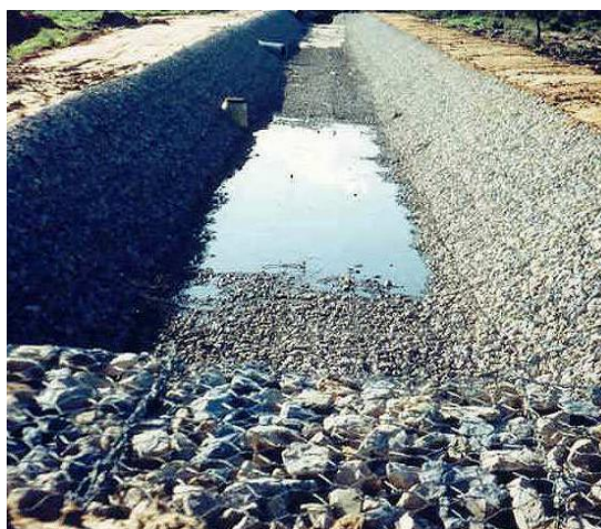
Figura 15. Revestimiento de canales para evitar la erosión con colchones de gaviones
