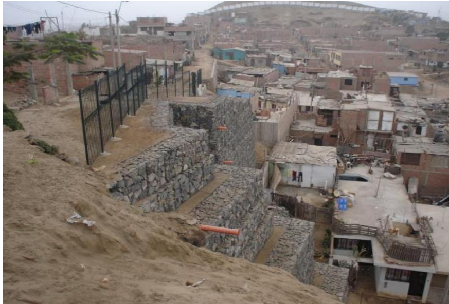
Figura 2. Muro de contención de gaviones en asentamientos humanos
