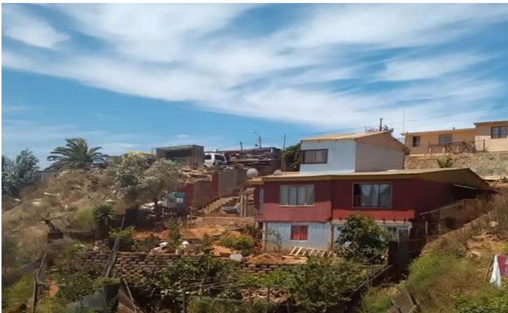
Figura 1. Muro de contención de caucho reciclado en el Cerro Las Cañas, Valparaíso
