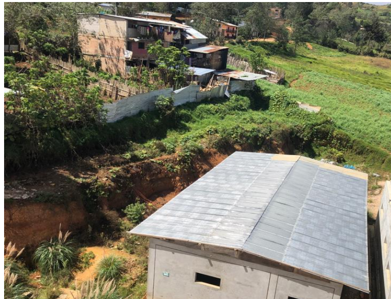
Figura 36. Tramo de talud arcilloso por contener
