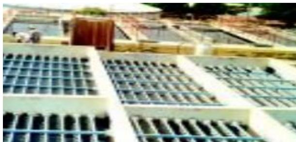
*Figura 11:* Floculador hidráulico en forma serpentina
