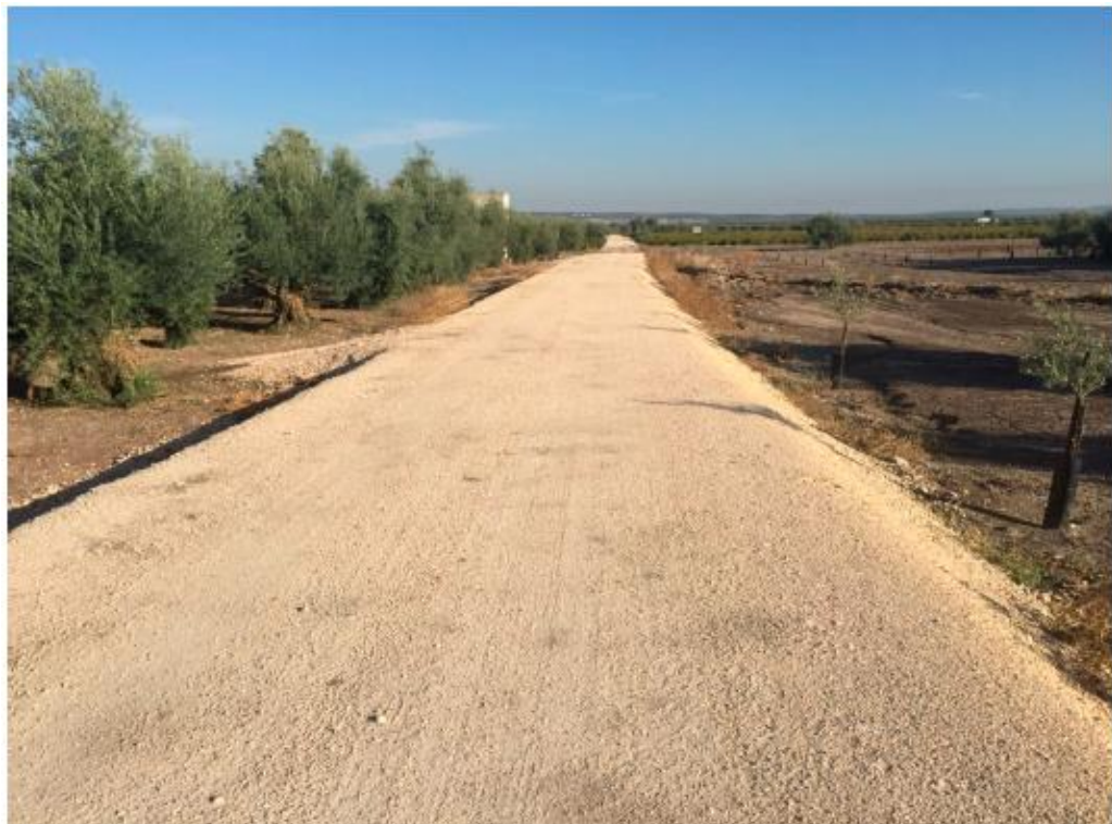
Figura 16: Viabilidad del uso de agregados reciclados mixtos no ligados de CDW sobre subrasante de arcilla expansiva en caminos rurales sin pavimentar.
