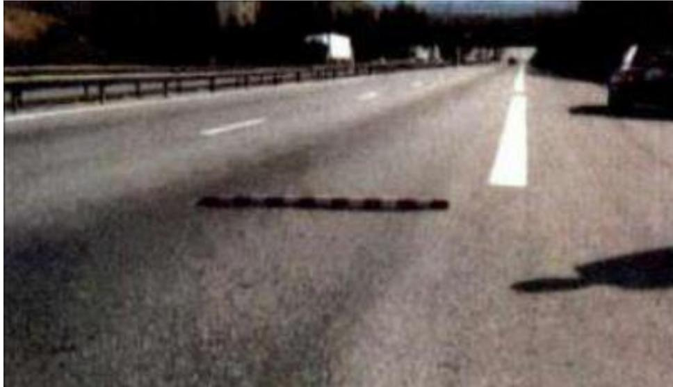
*Figura 8: Ahuellamiento en un pavimento flexible con un nivel de severidad bajo*
