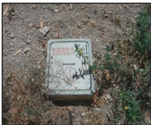
Figura 14: Obra civil de pozo de puesta a tierra
