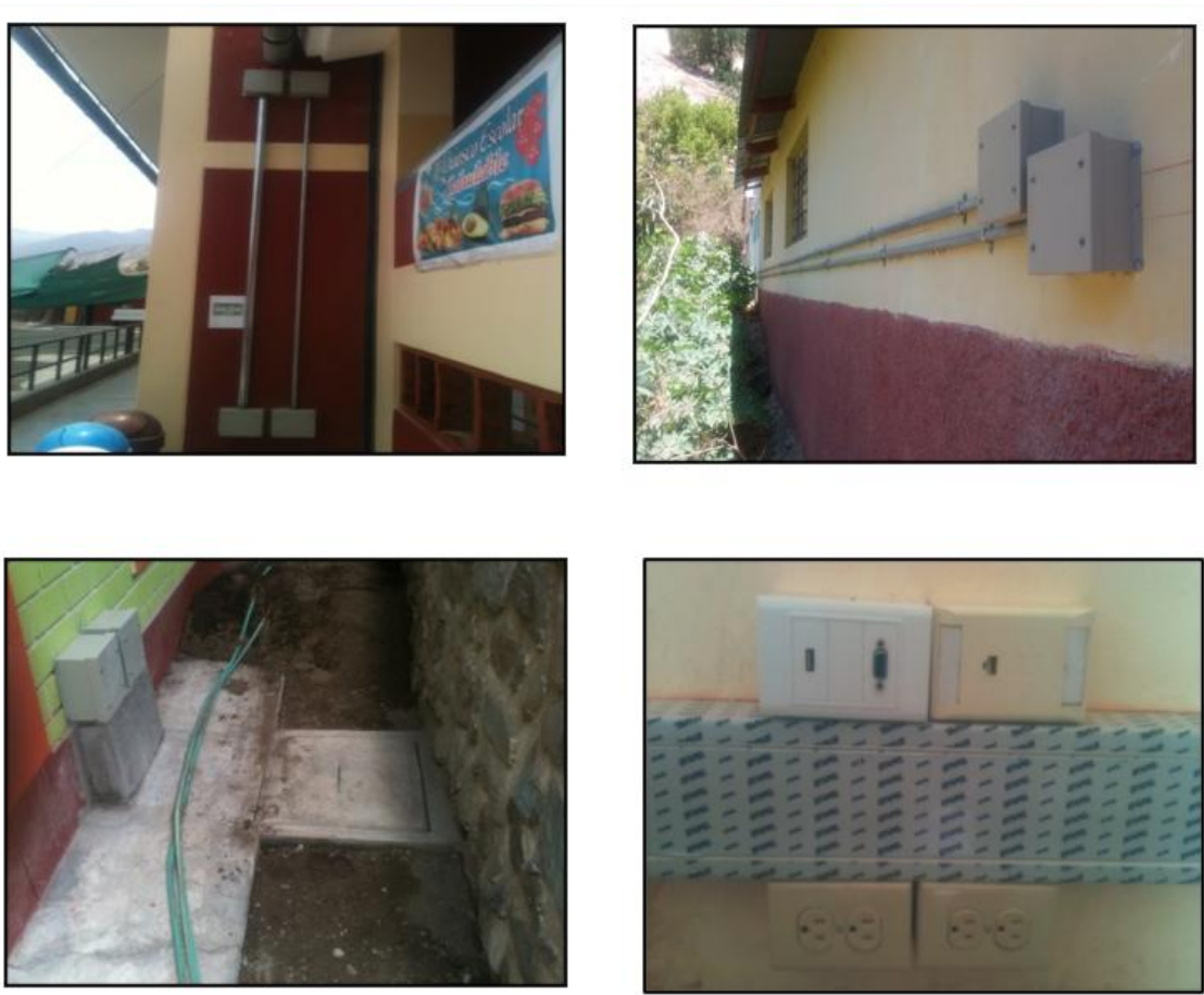
Figura 5: Trabajos de obra civil externo e interno de las aulas
