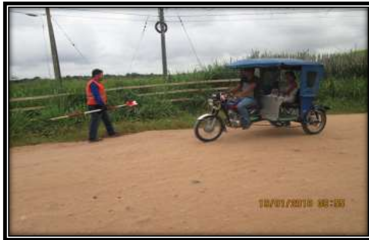
Figura 23: Deterioro de la capa de rodadura,
