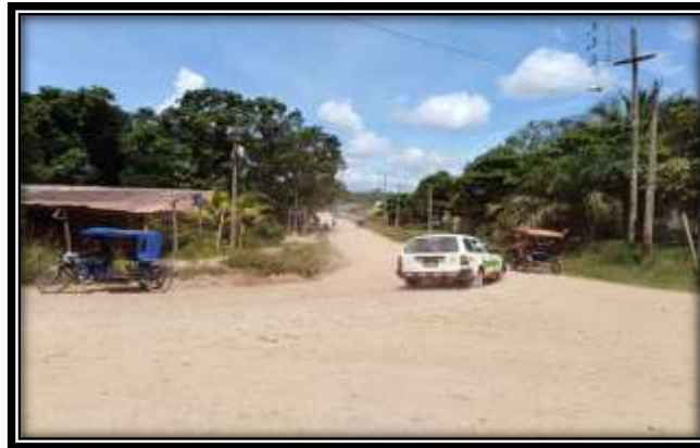
Figura 30: Final del tramo, se aprecia el deterioro de la capa de rodadura y la falta de cunetas
