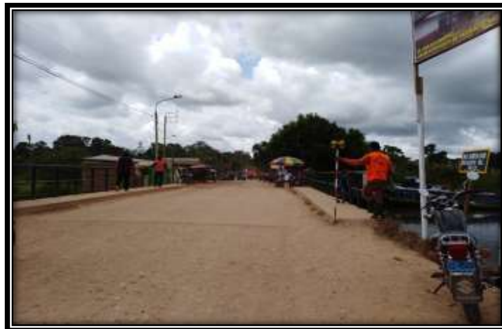
Figura 24: Puente existente viga-losa en buen estado
