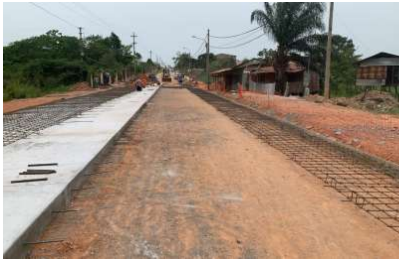
Figura 13: Pavimento de concreto reforzado con juntas
