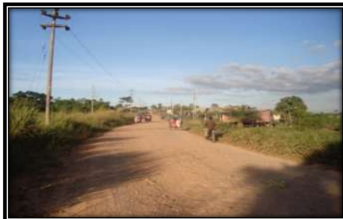
Figura 26: Otra vista del estado de la vía
