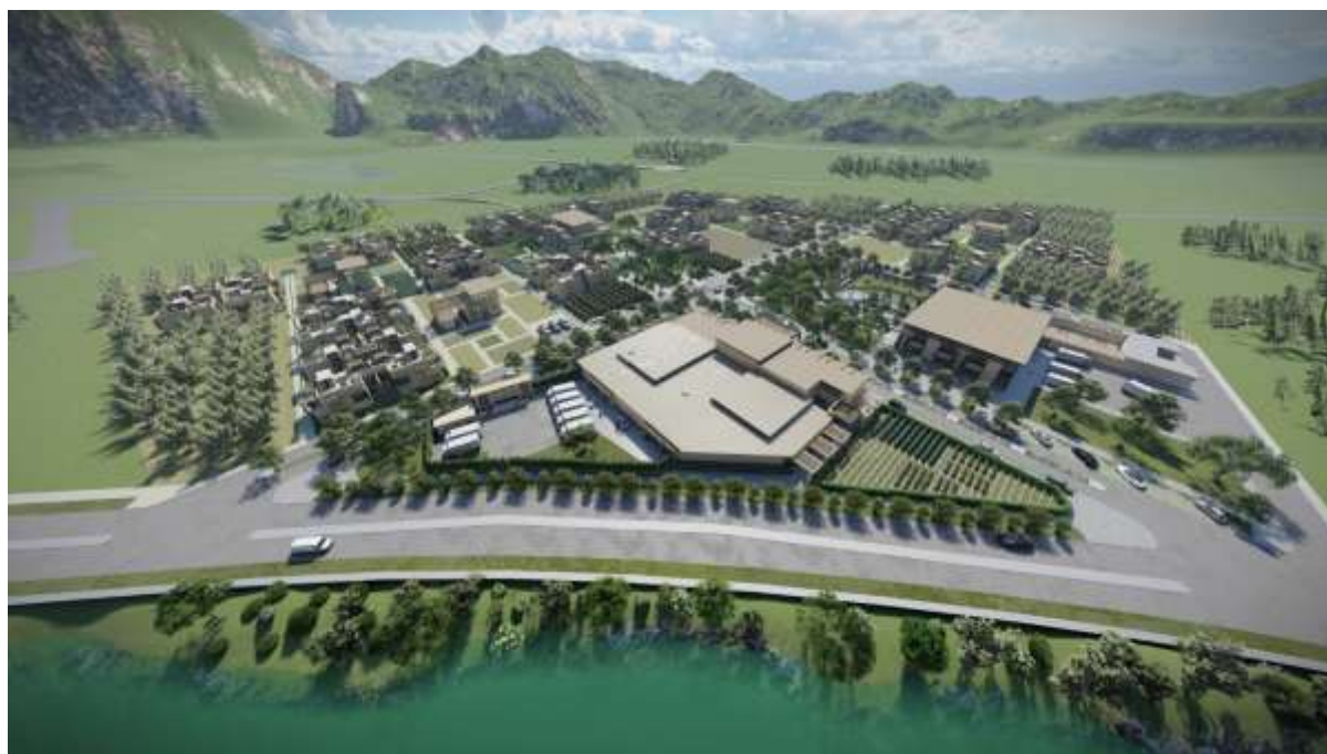
Figura 75. Vista general del proyecto Elaboración propia
