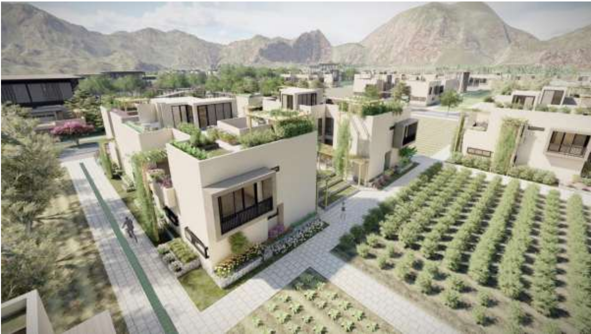
Figura 104. Vista general de las Viviendas - Módulo III (Tipo E y F) - vista 01 Elaboración propia
