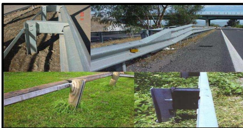
*Figura 3: Sistemas Semi-Flexibles o Semi Rigido por MSV 2016*
