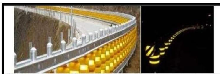
*Figura 24: Vista de la barrera rodante instalada en el campo curvo, tanto en sistema de reflexión diurna como nocturna, por “Presentación de estudio de caso sobre sistema de barrera rodante” por Academy of Engineering (2017)*
