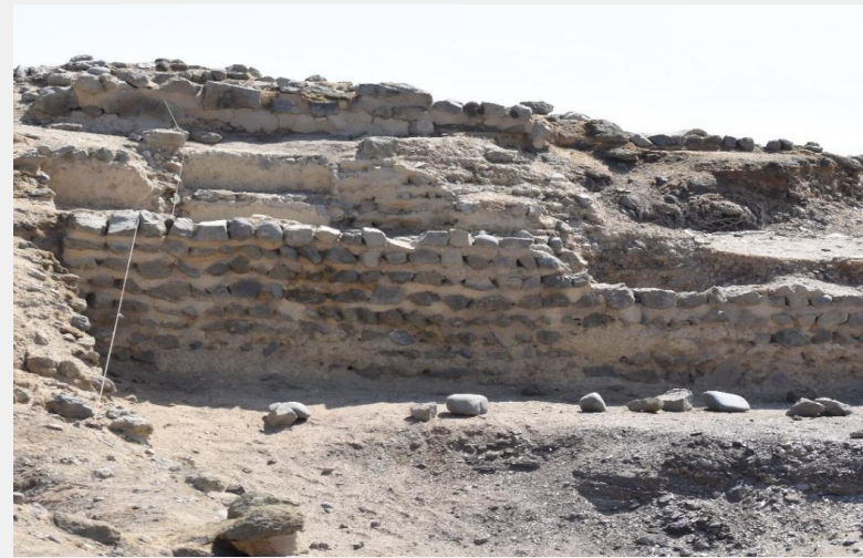
Figura 13. Detalle de los muros que contienen las Shicras
