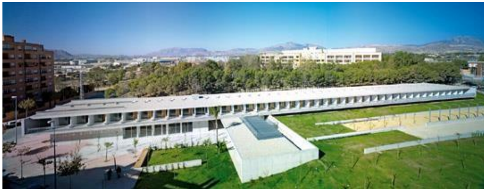
Figura 3: Fachada de las viviendas tuteladas y centro de día, San Vicente. Fuente : https://www.via-arquitectura.net/ara06/ara06-060.htm
