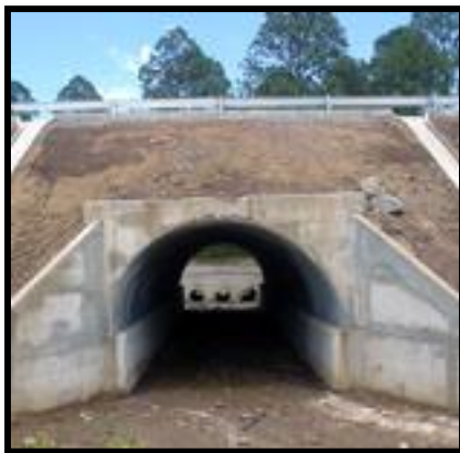
Figura 17: Vista frontal de un tipo de alcantarilla.
