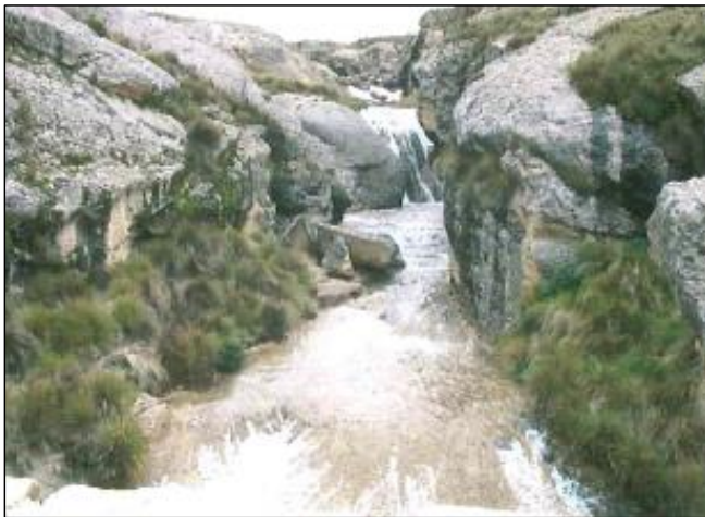
Figura 68: Imagen del cauce en la quebrada Escalón (Alcantarilla 125).
