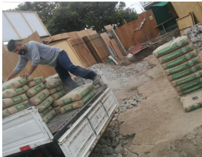
Abastecimiento de materiales
