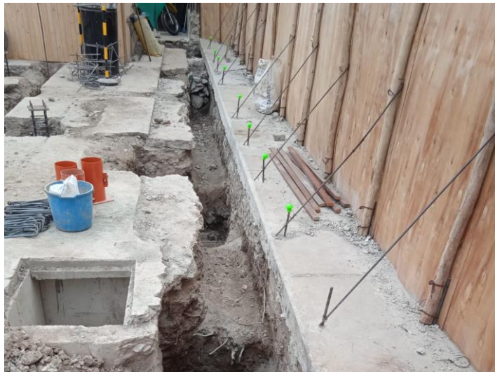
Excavación de zapatas y cimiento corrido
