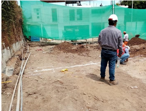
Ejecución de la partida de trazo y replanteo de terreno.
