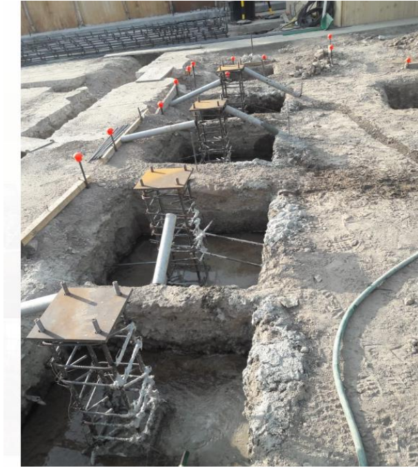
Pedestales para estructura metálica
