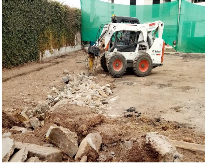
Ejecución de la partida de demolición de sardinel.
