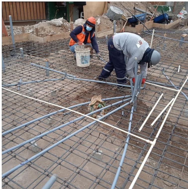
Habilitación de tuberías eléctrica.
