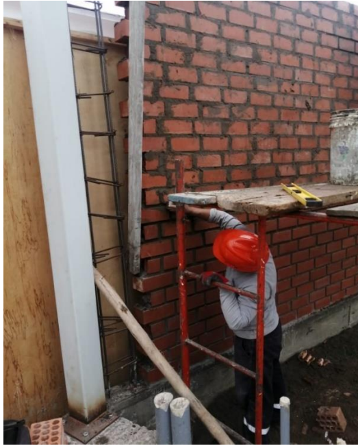
Construcción de muro de albañilería.
