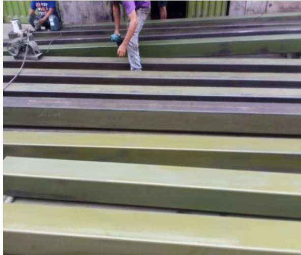
Taller de estructura metálica
