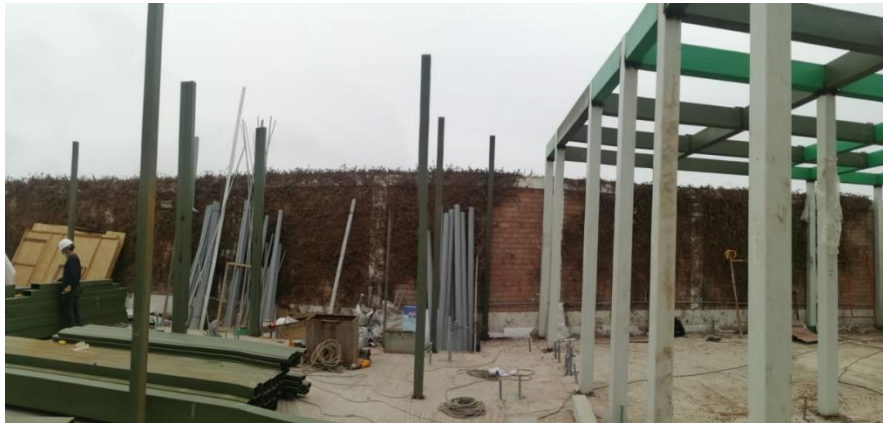
Izaje y soldadura de columnas y vigas.
