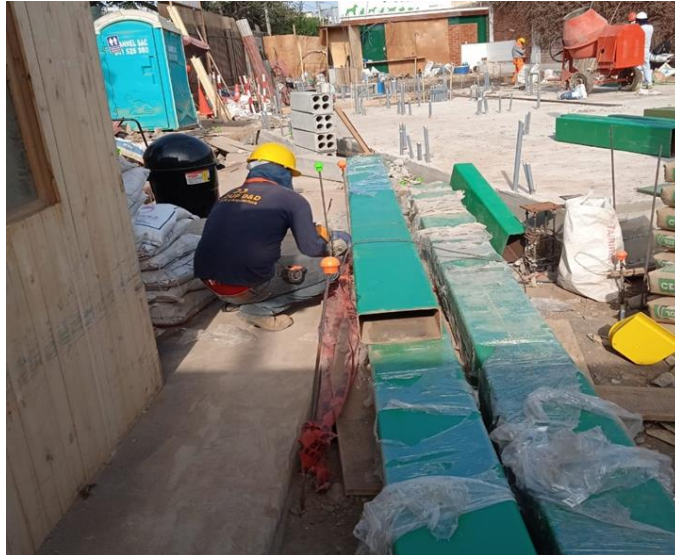
Habilitación de columnas metálicas
