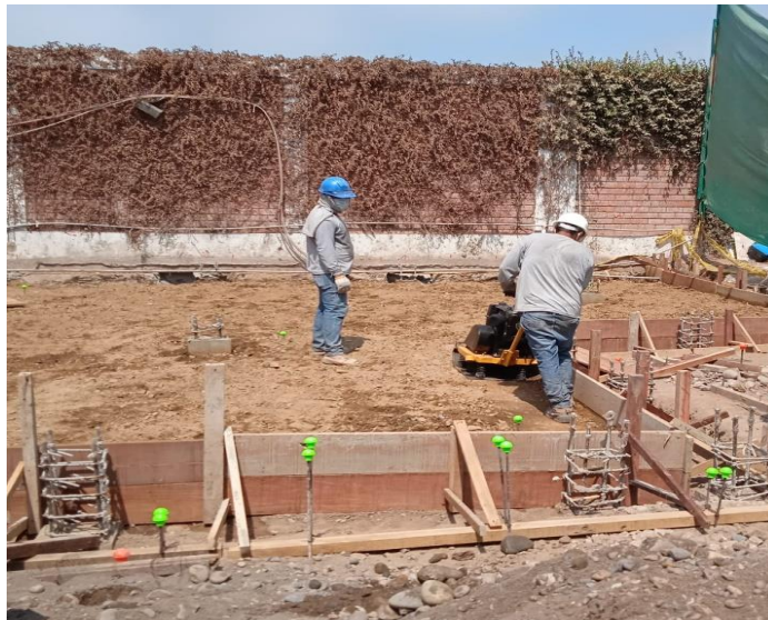
Relleno y compactación para losa
