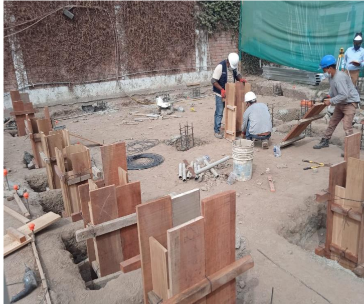
Encofrado y desencofrado de pedestales
