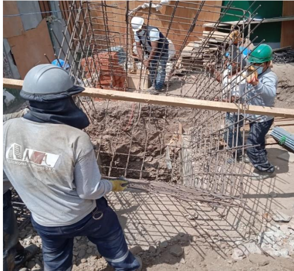
Habilitación de acero para cisterna
