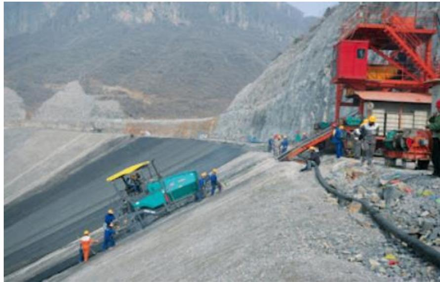
Figura N° 8: Extendedora de concreto asfáltico.
