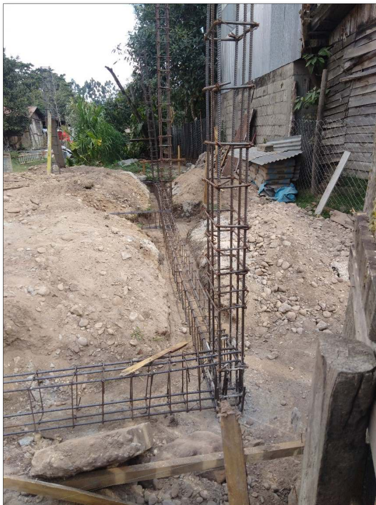
Figura 38: Obra en ejecución
