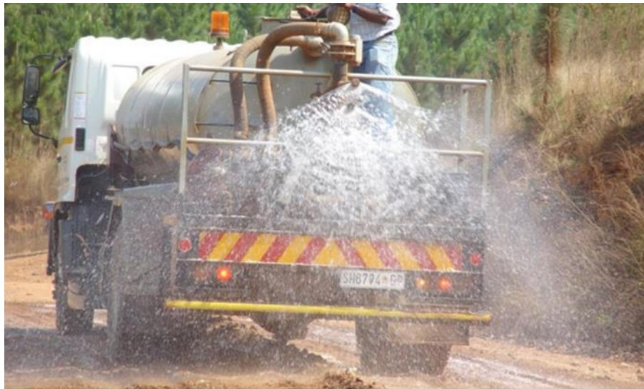
Figura 1: Control de polvo mediante riego
