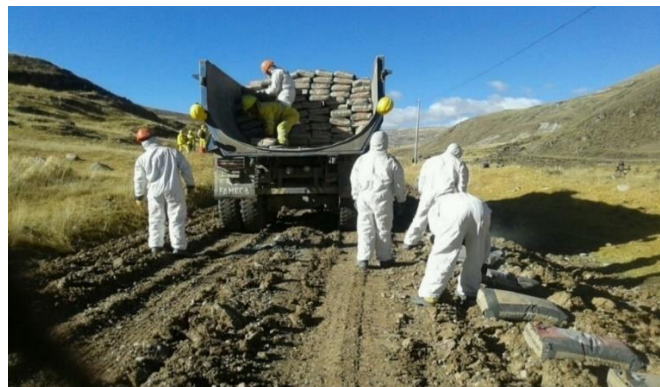
Figura 20: Volquete con bolsas de cemento (usado para acarreo de materiales)
