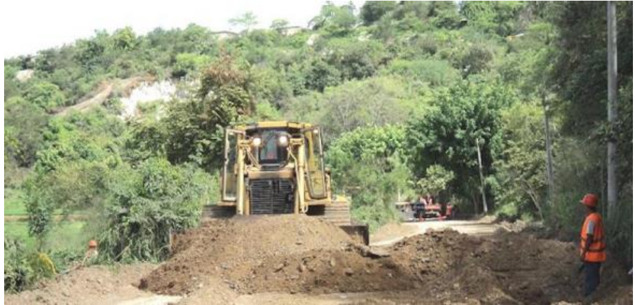
Figura 2: Perfilado de superficie con aporte de material
