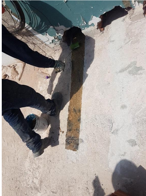
Figura N° 4: Zona restaurada antes de Imprimación
