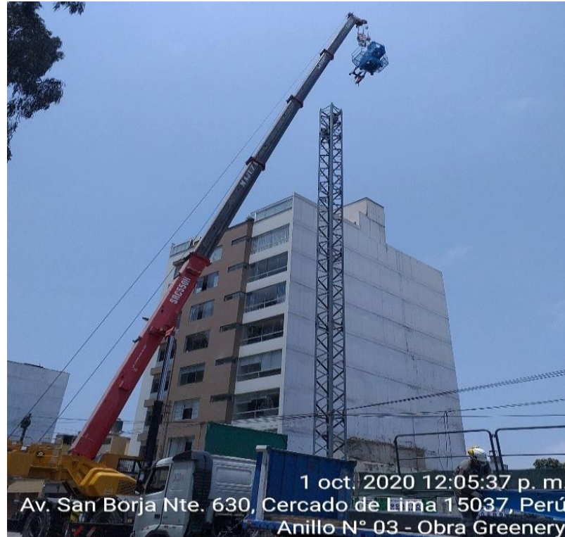
Figura 25. Armado de torre grúa (Fuente: Elaboración Propia)
