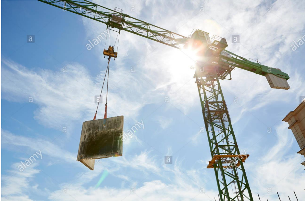
Figura 26. Torre grúa transportando materiales (Fuente: Grisco Equipo de Construcción, 2019)
