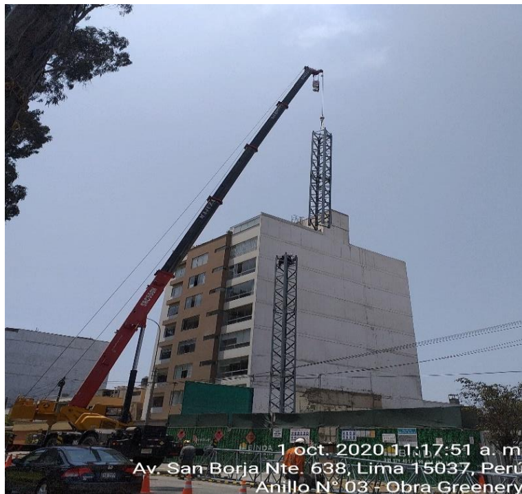
Figura 27. Torre grúa en proceso de armado (Fuente: Propia)
