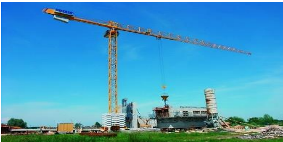
Figura 2. Torre grúa como imagen de la construcción (Fuente: Grupo Digama, 2015)
