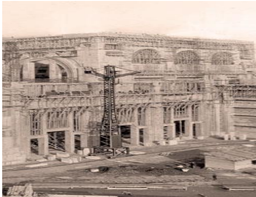
Figura 1. Elevación torre grúa. (Fuente: Integral Equipos y soluciones, 2020)
