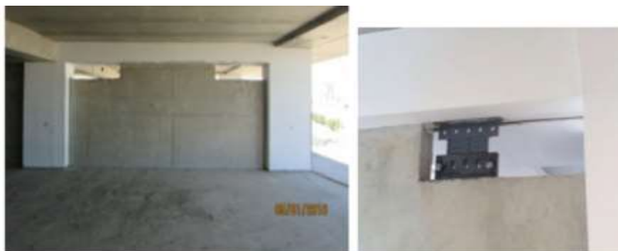
Figura 7: Muro desacoplado con disipador de energía incorporado
