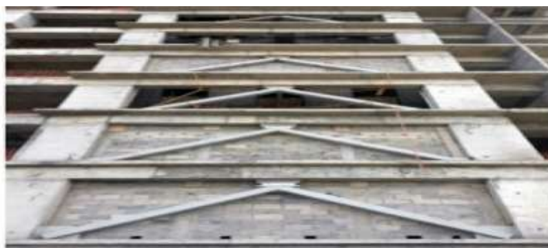
Figura 8: Disipador tipo Chevron
