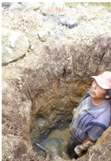
Figura N° 34: Descripción del material que se encuentra en una calicata
