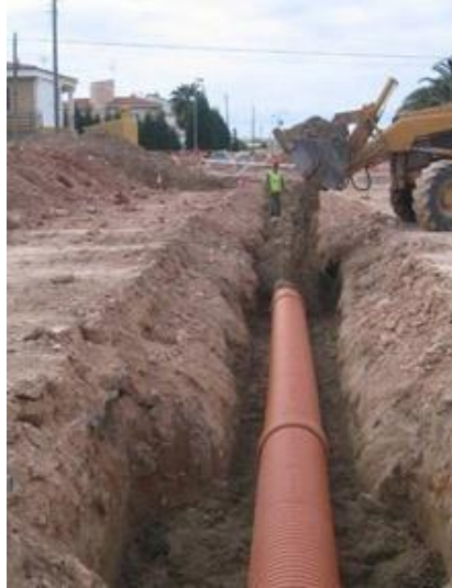
Figura N° 32: Excavación de zanja para colocación de tubería de alcantarillado
