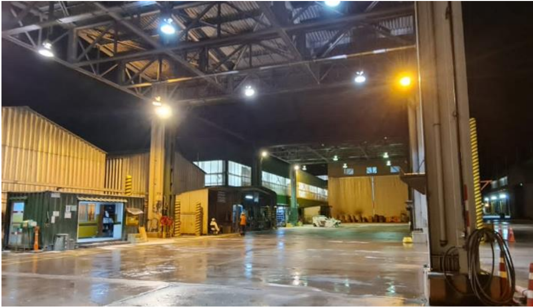
Figura N° 2: Bahías de los talleres nuevos
