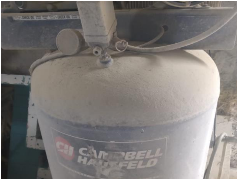
Figura 31. Estado previo de compresor de Novofibras
