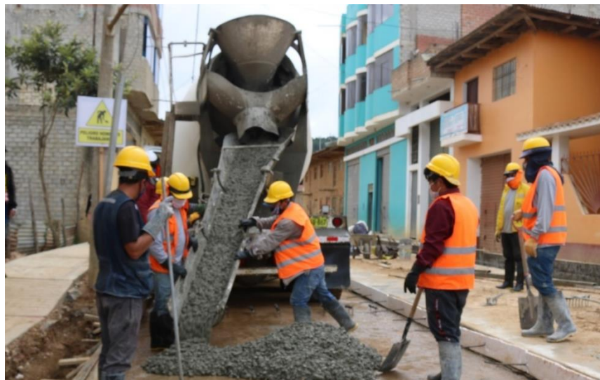
Figura N° 28: No uso de protección auditiva en obra 2019
