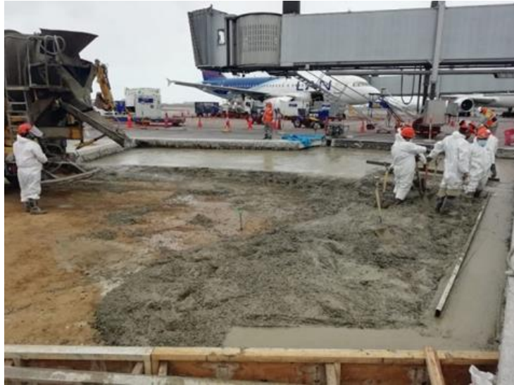
Figura N° 36: Resane pista de aterrizaje AIJCH
