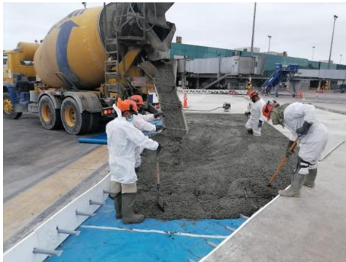
Figura N° 37: Resane pista de aterrizaje AIJCH
